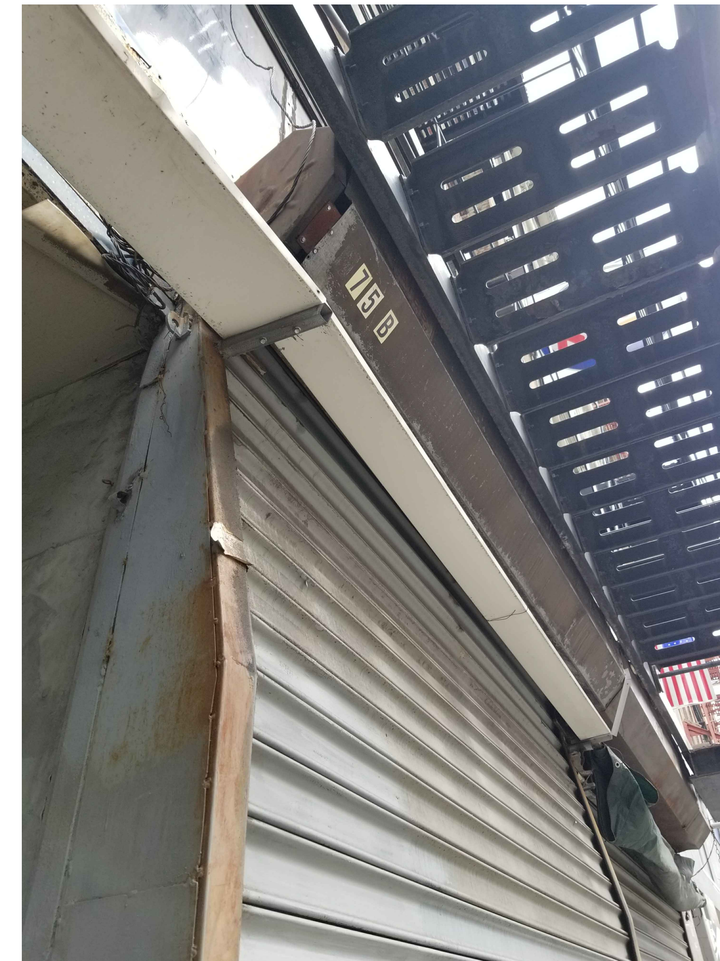
07 EXISTING ROLL DOWN DOOR
